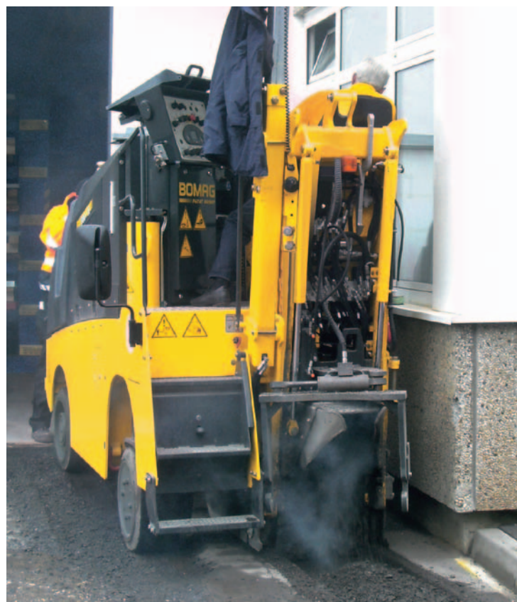
Точный подъезд к стене дома? Без проблем.
