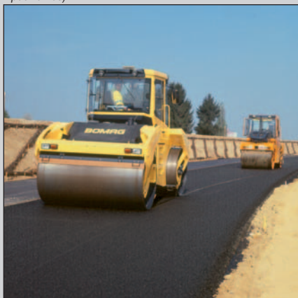
Обычно используется на больших строительных площадках: BW 203 AD с большой мощностью на единицу поверхности.
