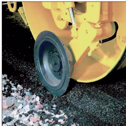
Эффективная обработка кромок с помощью режущего диска или прижимных роликов.
